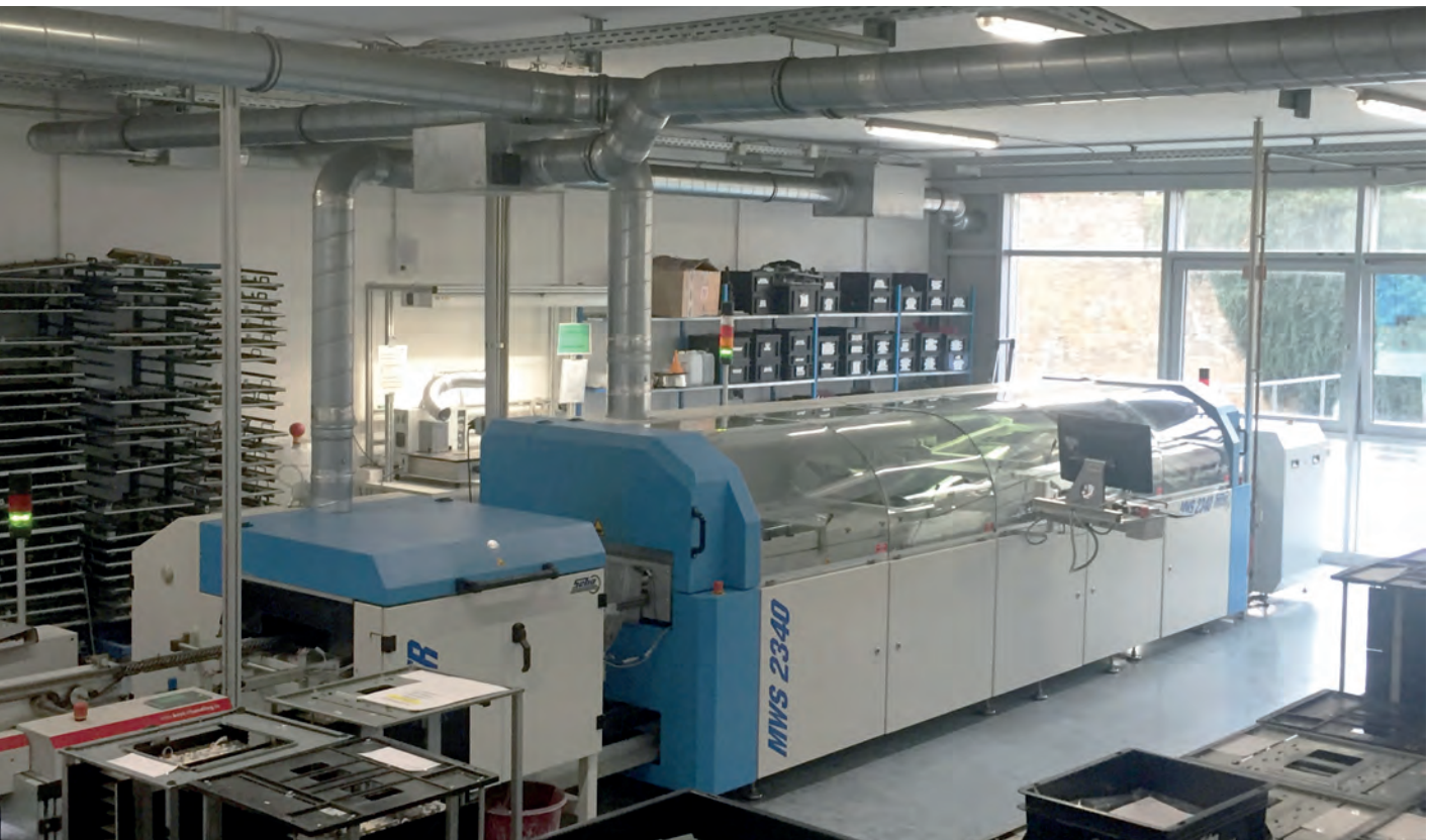
Die Produktionshalle von VTQ Videotronic mit Wellenlötanlage.
