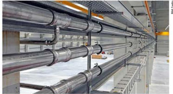
3 Die Druckluft- und Kühlwasserleitungen wurden mit dem Sanha NiroSan-Presssystem realisiert.
