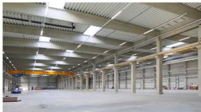
2 Die Produktionshalle umfasst rund 9400 m<sup>2</sup> und ist als Beton-Fertigteile-Konstruktion nach neuestem Standard gefertigt worden.
