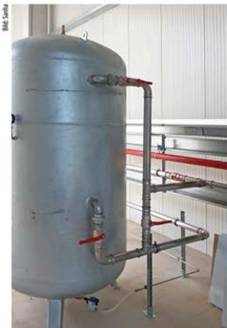
5 Druckluftspeicher gewährleisten einen schwankungsfreien Betrieb der Anlage.
